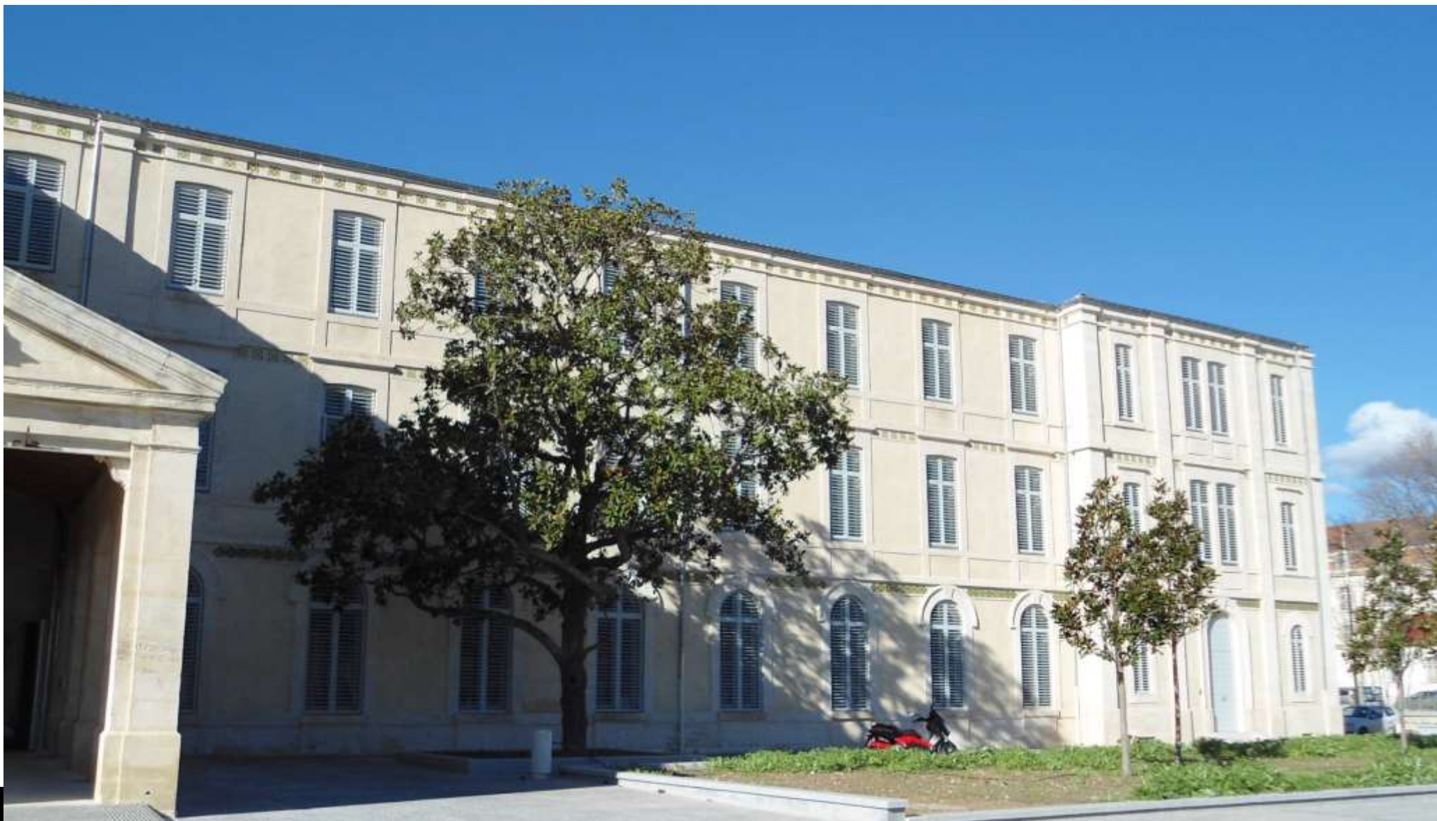
Façade sur rue, aile réhabilitée
