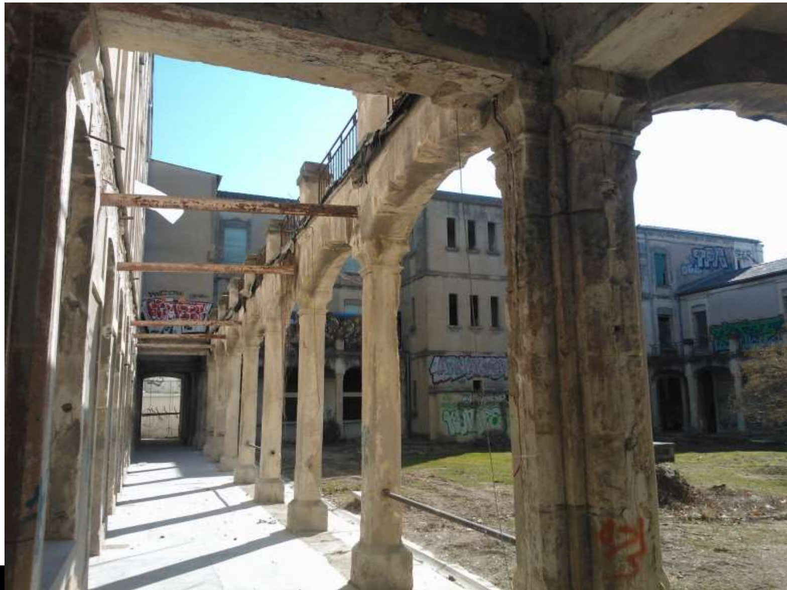
Patio avant travaux
