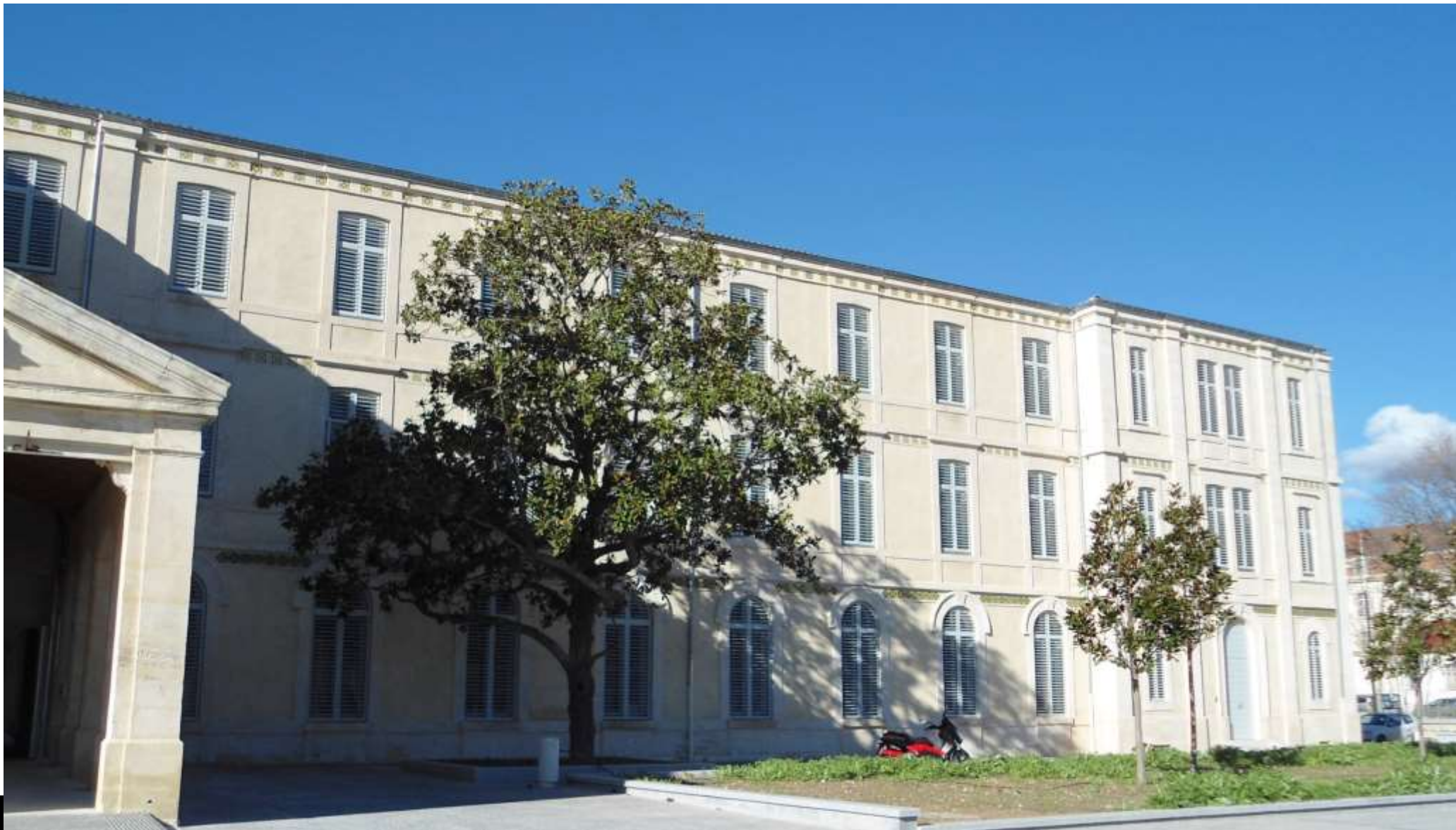
Façade sur rue, aile réhabilitée
