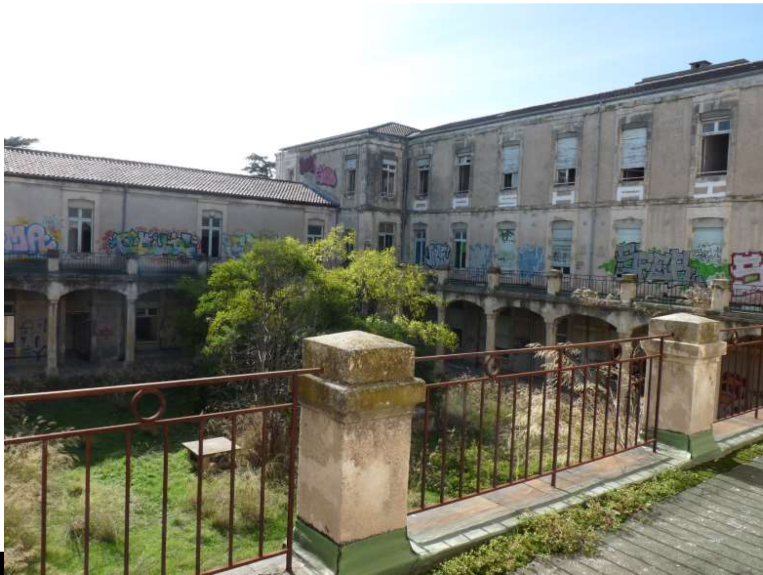
Patio avant travaux
