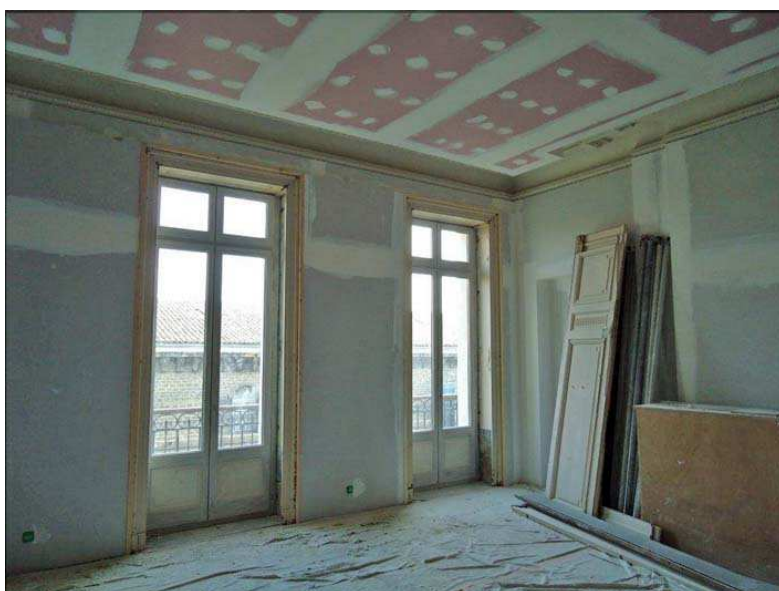
Doublage intérieur des pièces sur rue : avant et après.
